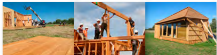
Construction d'un pavillon prototype la Maison du Parc Carentan-les-Marais (St-Côme-du-Mont)
