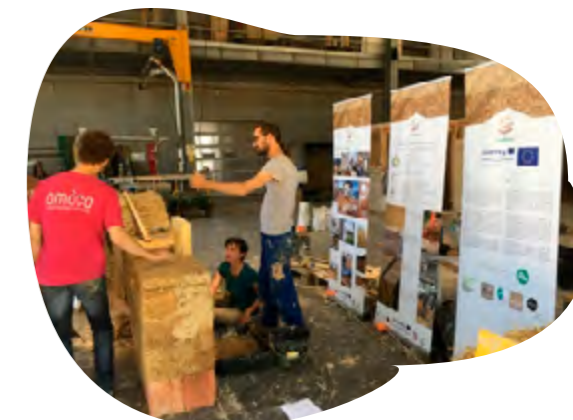
Construction d'un bâtiment expérimental à la ferme du Bas Quesnay - Saint-André-de-Bohon
