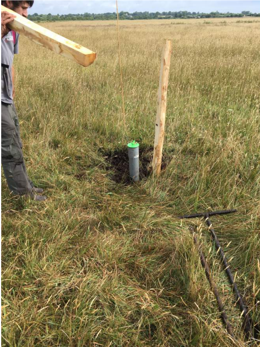
Pose d'un piézomètre
