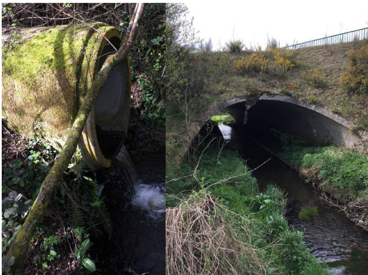
Ouvrage à très fort risque à gauche et à risque moyen à droite
