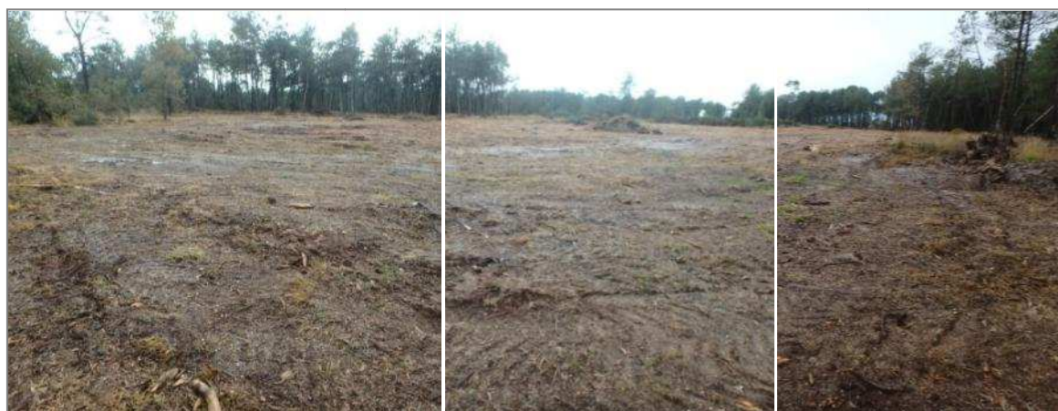
Broyage de la végétation – novembre 2019 © CPIE
