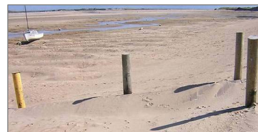
Partie finale de la cale d'accès
