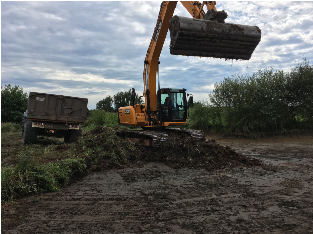
Curage d'une partie de la mare à Cavigny
