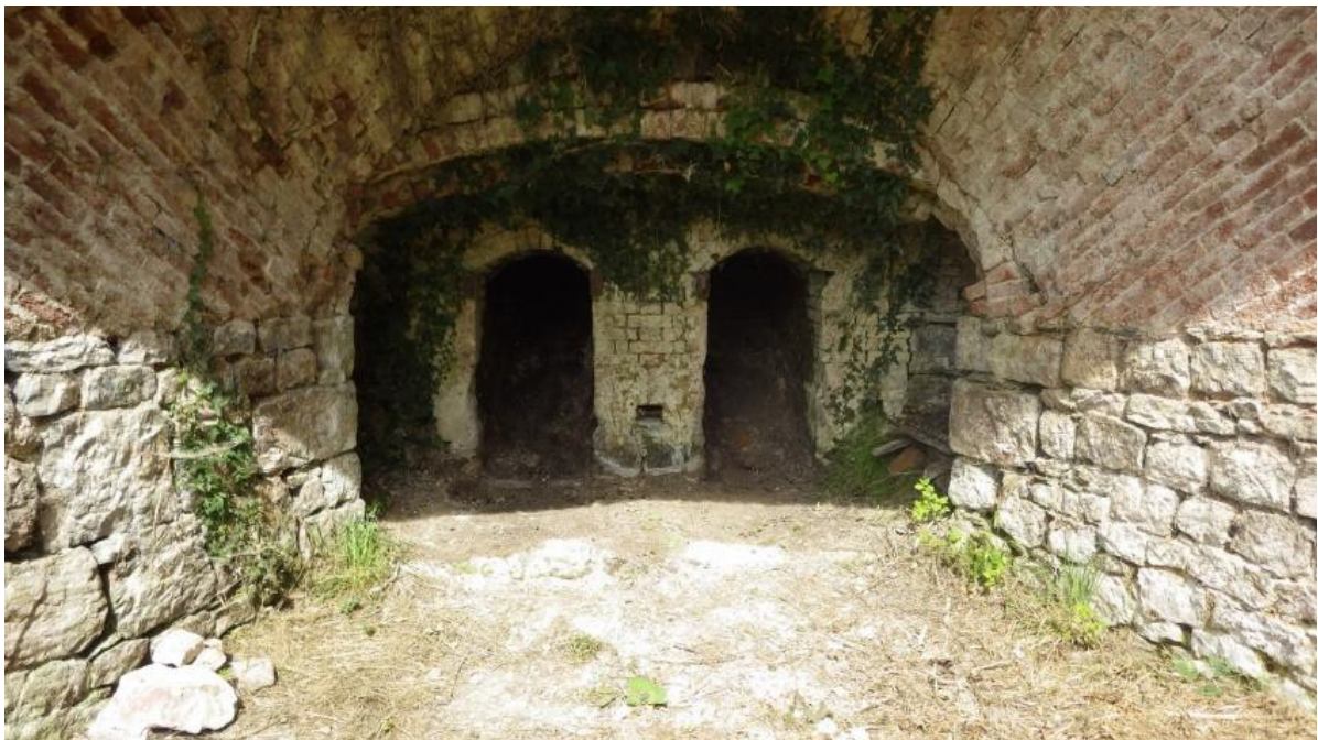
Dégagement de l'entrée des fours du Hamel Bazire Nord
