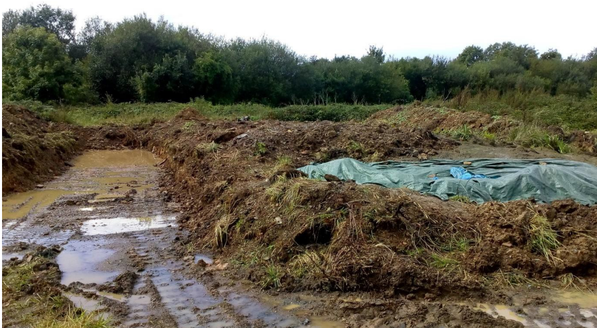
Zone de stockage à La Meauffe
