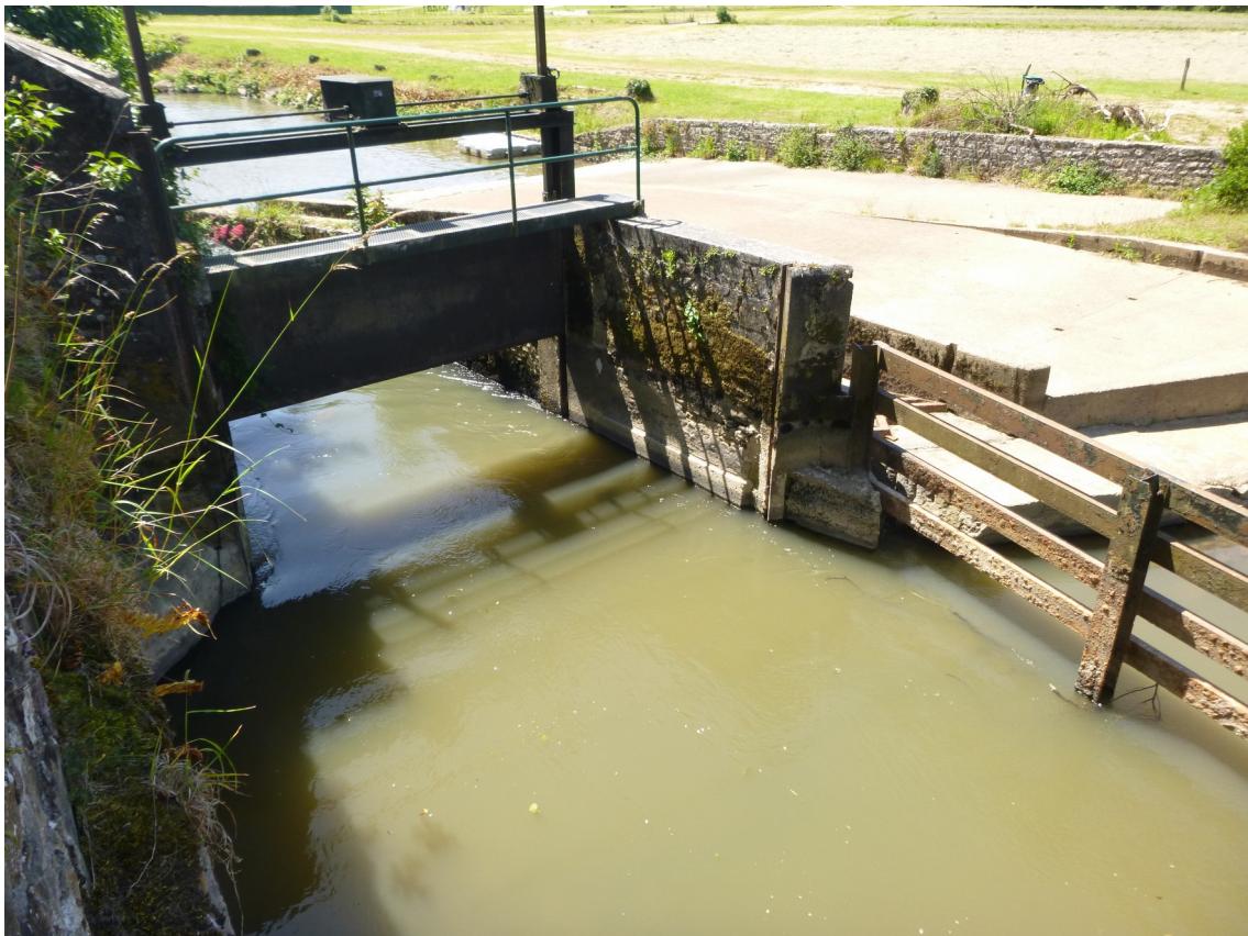
Ouvrage du moulin Férey sur la Douve
