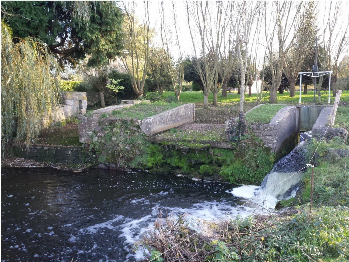
Ouvrage du Moulin du Mesnil sur la Taute
