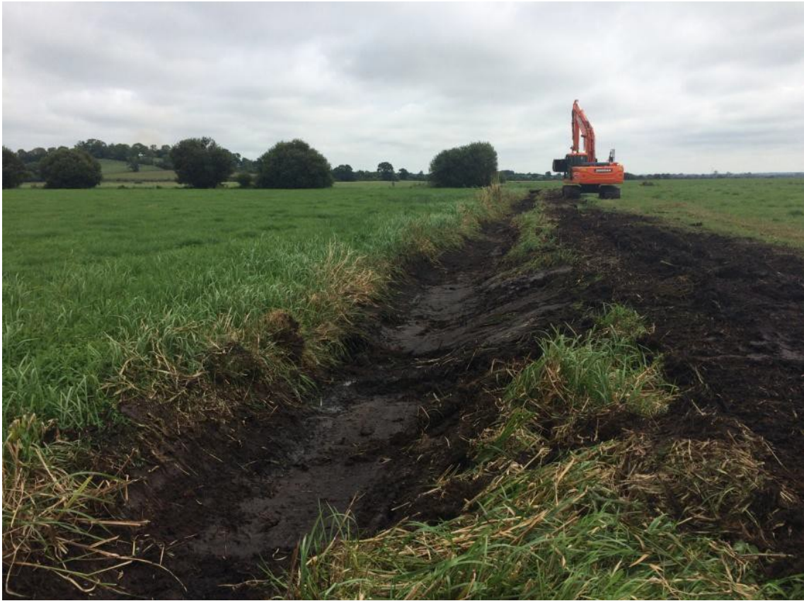
Curage de fossé – RNR Taute
